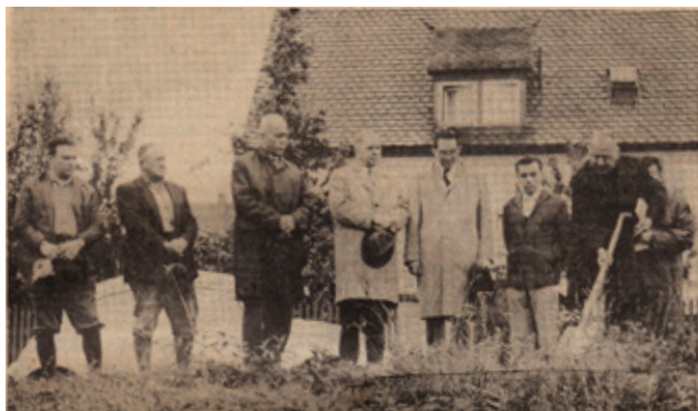
Erster Spatenstich 1. September 1965
